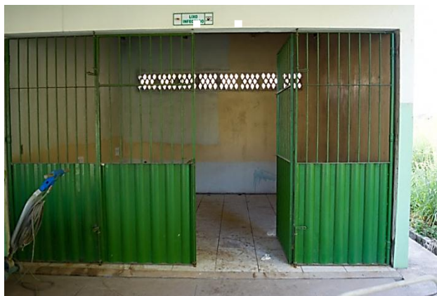
Figura 5 – Vista Frontal da Sala de Armamento Temporário. Fonte: Autores, 2015.
